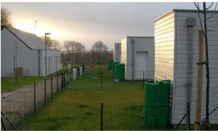
Récupération des eaux pluviales dans un quartier de Guisriff.
