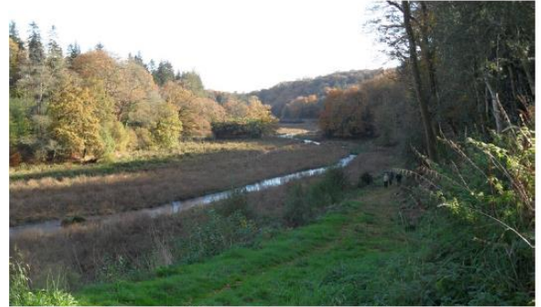
Rétablissement d'une continuité de cours d'eau au niveau de l'étang de Pontcallec.
