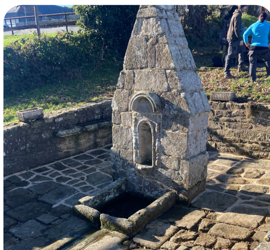
Chantier Nature et Patrimoine - Exemple de réalisation
