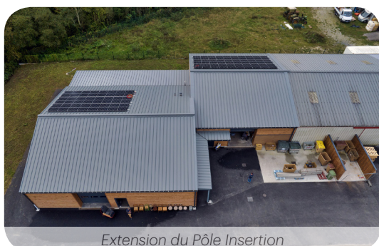
Extension du Pôle Insertion
