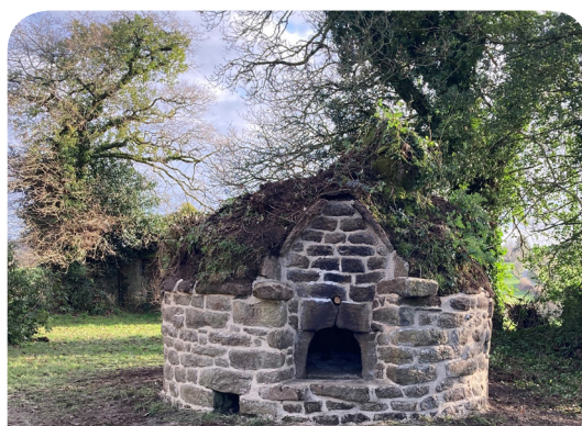
Chantier Nature et Patrimoine - Exemple de réalisation
